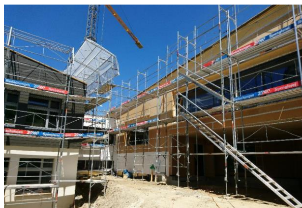
Aktueller Stand Neubau und Sanierung KG-Pfarreiheim
