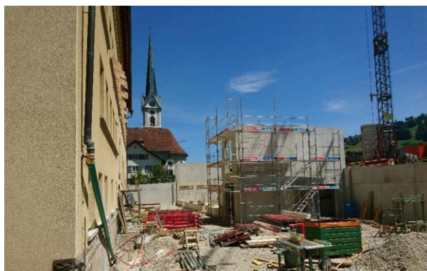
Aktueller Stand Ergänzungsbau Schulhaus Dorf
